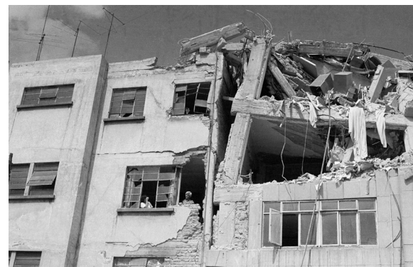
Edificios afectados por el terremoto. 19 de septiembre de 1985. © Elsa Medina
