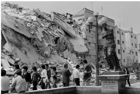
Edificios afectados por el terremoto en el cruce de las avenidas Álvaro Obregón e Insurgentes. 19 de septiembre de 1985. © Elsa Medina
